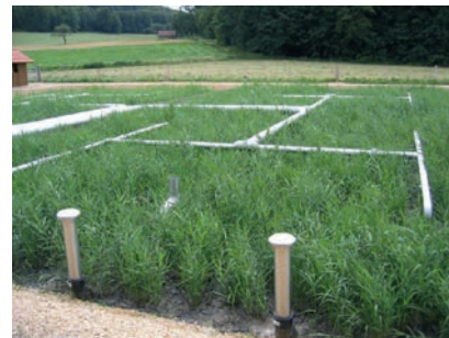
Filtre planté de roseaux
